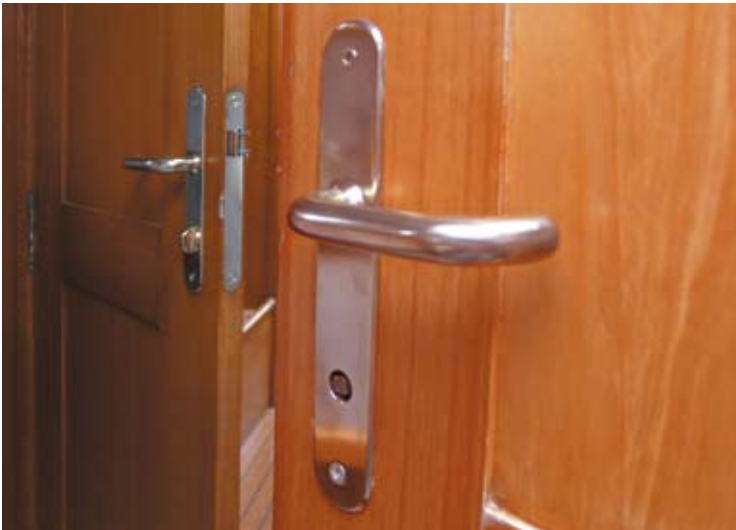
Las cerraduras y manetas restauradas dan un rejuvenecido aire a los interiores del barco
