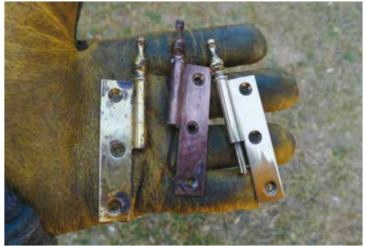
Antes, durante y después de la limpieza y pulido en tres bisagras. Tras pasar por ácido oxálico, la bisagra coge un tono rosado que el posterior pulido vuelve a convertir de dorado brillante
