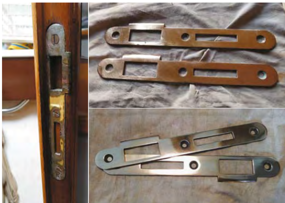
Así estaban las chapas de las cerraduras en las puertas antes del refit. Un buen cepillado eliminó el óxido superficial y el posterior pulido recobró el brillo original de la pieza
