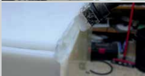
Para rellenar las esquinas abiertas que quedan en el exterior y dar la necesaria consistencia a los tanques se utiliza una máquina que 'escupe' polietileno fundido
