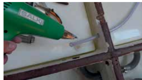
La pistola de calor es una inestimable ayuda para domesticar el giro de las mangueras y su entrada en los distintos entronques
