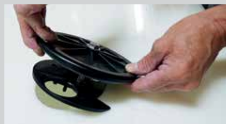
Las tapas de registro con su junta tórica se atornillan en el agujero que se ha hecho en los lugares marcados
