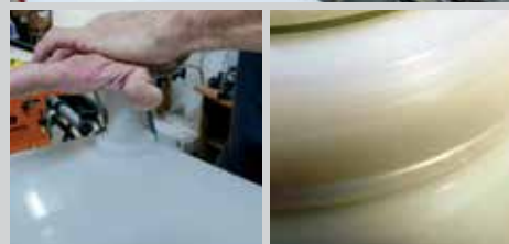
La base roscada de los entronques se suelda a los depósitos mediante una resistencia eléctrica que calienta los terminales macho y hembra a la vez hasta fundirlos en superficie. En ese momento y mediante un rápido gesto, el técnico aparta la resistencia y une las dos piezas entre sí de forma indeleble. En el detalle se aprecia la corona de polietileno fundido (luego solidificado) que se escupe entre el entronque y los paneles del depósito
